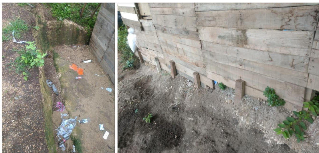
Imagen 12. Intervención del terreno a través de cortes (izquierda) y rellenos (derecha) para construcción de estructura de madera. Sector Bendición de Dios.
