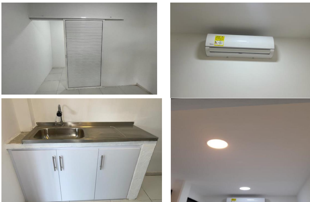
Imagen 61. Adecuaciones consultorio veterinario
