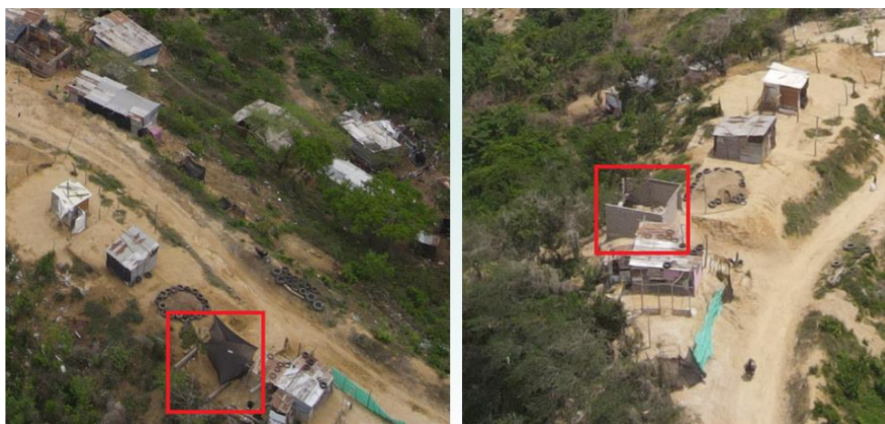
Imagen 19. Avance de la construcción en un punto identificado en Kennedy – 29 de abril (izquierda) 13 de mayo (derecha).
