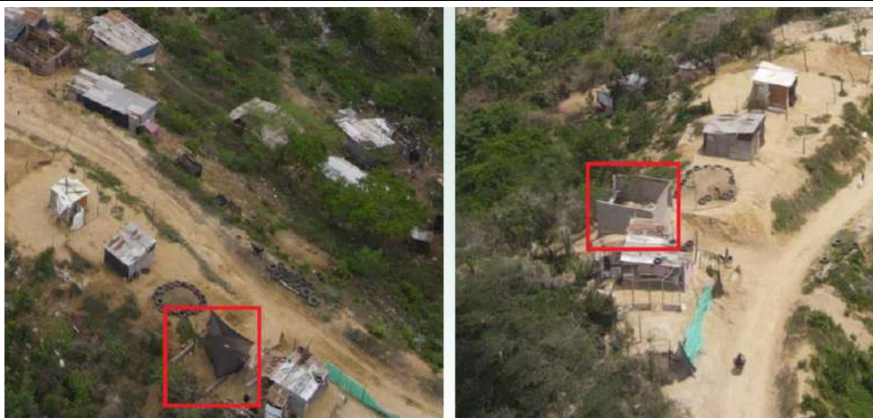
Imagen 34. Avance de la construcción en un punto identificado en Kennedy – 29 de abril (izquierda) 13 de mayo (derecha).
