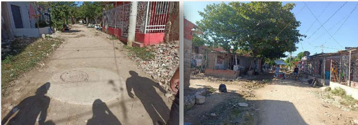
Imagen 111. Vías en mal estado
