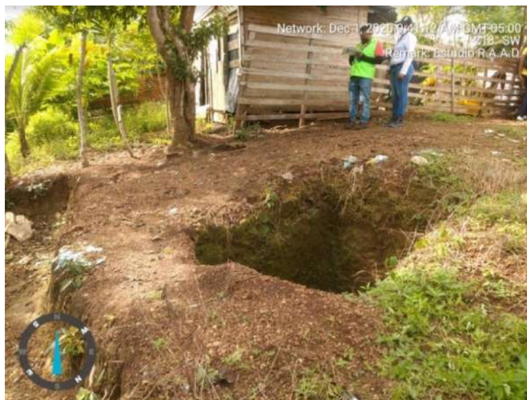
Imagen 30. Identificación de excavación para posa séptica en la Bendición de Dios.
