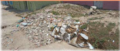
Disposición inadecuada de residuos de construcción y demolición - RCD
