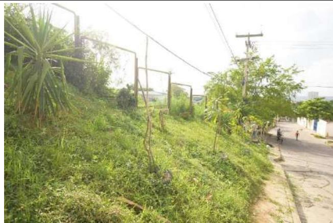
Mantenimiento Zaragocilla Junio 2022
