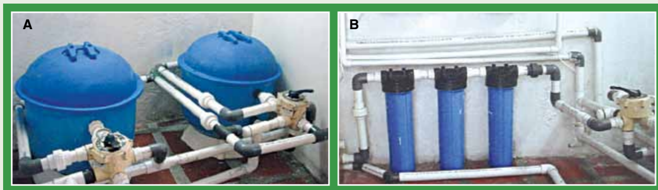
Figura 9. Sistema de filtración del LABBIP. Filtros de arena (A) y de cartucho (B).
