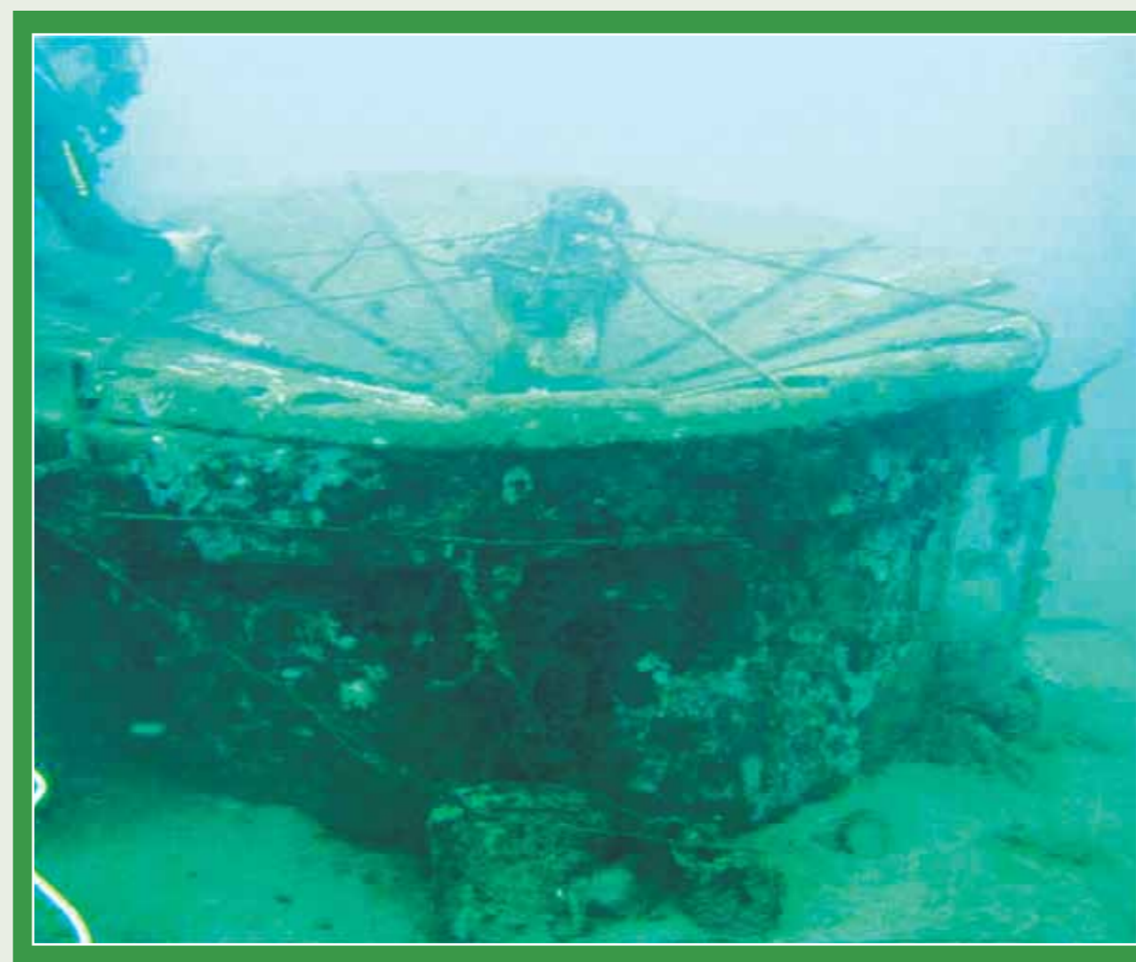
Figura 12. Estado antes del mantenimiento del filtro sumergido de la toma de agua del LABBIP.
