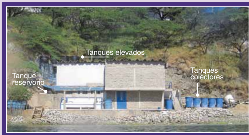
Figura 9. Vista del tanque reservorio y los tanques elevados y colectores del LABBIP.
