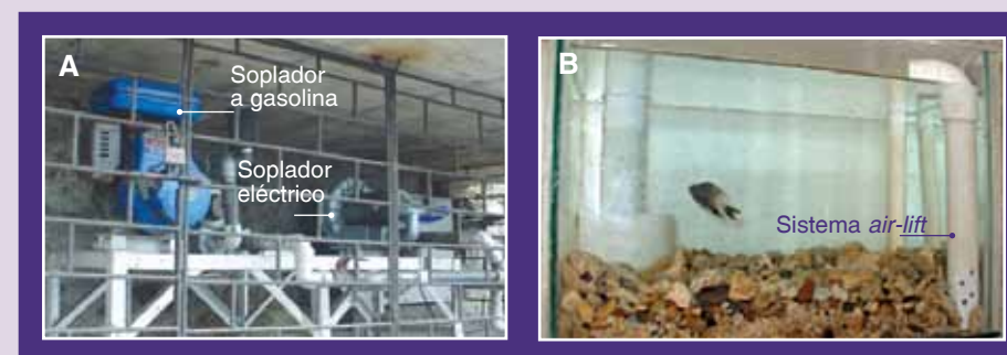
Figura 12. Sopladores por duplicado (A) y aeración con air – lift (B) del LABBIP.
