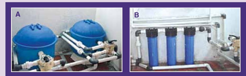
Figura 10. Filtros de arena (A) y de cartucho (B) del LABBIP.
