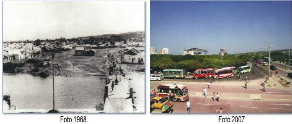
Figura 30. Puente de la Trasmoforación Nacional sector Chambacú
