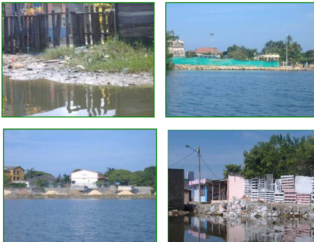
Figura 42. Rellenos hechos en el sector Cabrero - Marbella
