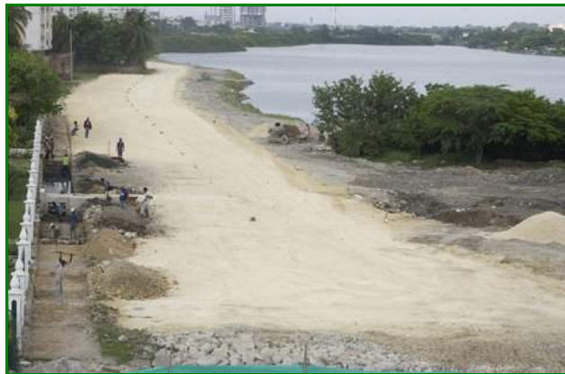
Figura 38. Construcción de la 3 Avenida de Cabrero.
