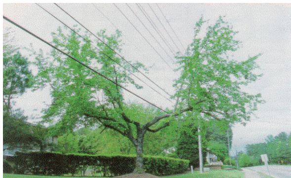
Poda direccional bajo conductores de alta tensión.
