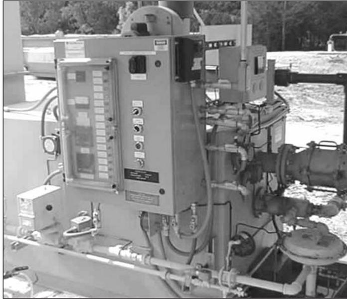
Figura 10. Equipo de extracción al vacío para realizar Bioventing (Fuente: Applied Hydrology Associates Inc, 2004)
