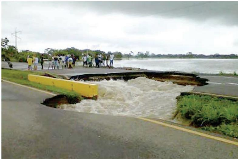
Figura 3. Registros de daños en la vía Cartagena-Barranquilla (vía alterna) durante las lluvias del año 2011.
