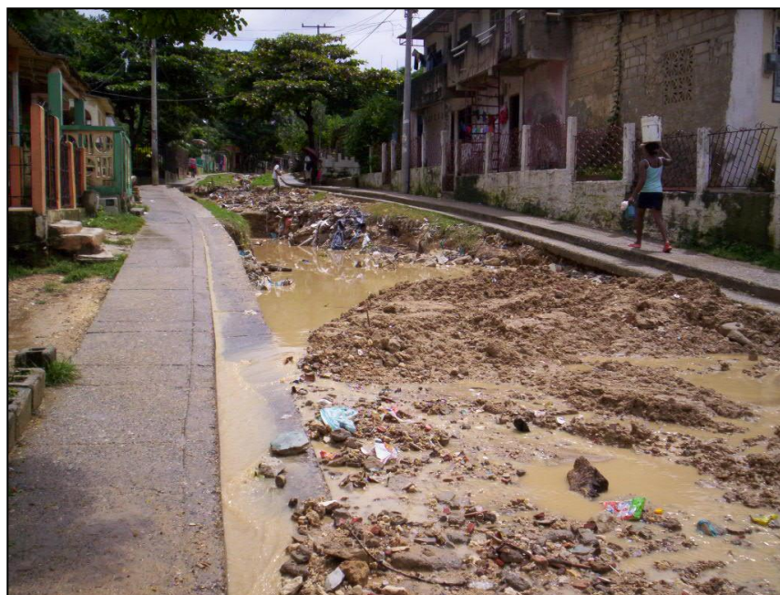
Flujo de detritos que afecta la Calle 64, al norte del Cerro de la Popa. Foto: G. Barbosa, 2009
