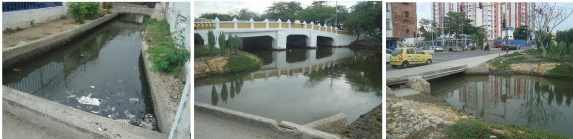
Figura 219. Canal NOE. Transporta agua de color oscuro y mal olor. Ancho aproximado 4.2 m. Coordenada: N 10°24'53.6" W 75°31'55.4".
