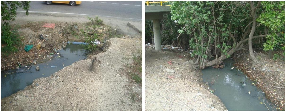
**Figura 211. Drenaje pluvial con presencia de algunos residuos sólidos. Ancho de 4.5m aproximadamente. El agua que transporta tiene color oscuro y mal olor. Presencia de tubería de gas. Coordenada: N 10°26'32.6" W 75°31'25.3".**
