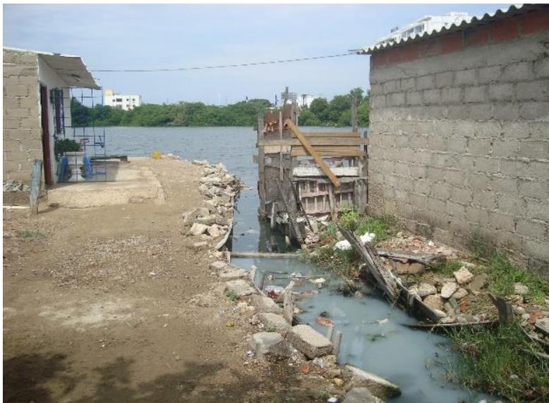
**Figura 215. Canal de vertimiento de aguas residuales de las viviendas aledañas hacia la Laguna del Cabrero. Con presencia de vegetación. Ancho de 0.8m aproximadamente. Coordenada: N 10°25'55.37" W 75°32'17.38".**
